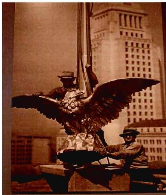
ภาพ 7 การติดตั้งตัวสัญลักษณ์นกอินทรีบนคานฟ้าของสำนักงานหนังสือพิมพ์แอลเอไทม์
